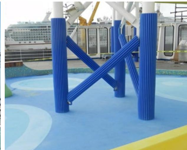
PILASTRI PONTE | MAXIONDA 28 MM
