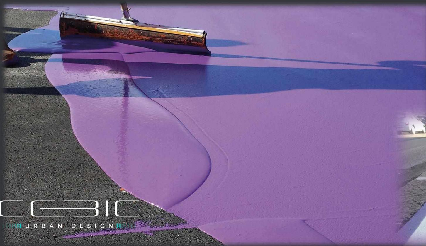
La posa viene eseguita con spatole in gomma in due mani con una resa minima di 1,9 kg/mq (in base alla porosità delle superfici). Il prodotto viene versato sull'asfalto e spatolato fino all'otturazione delle superfici ottenendo così una vera e propria rasatura, con la seconda mano si ottiene una finitura omogenea ed antiscivolo (BPN 60)
