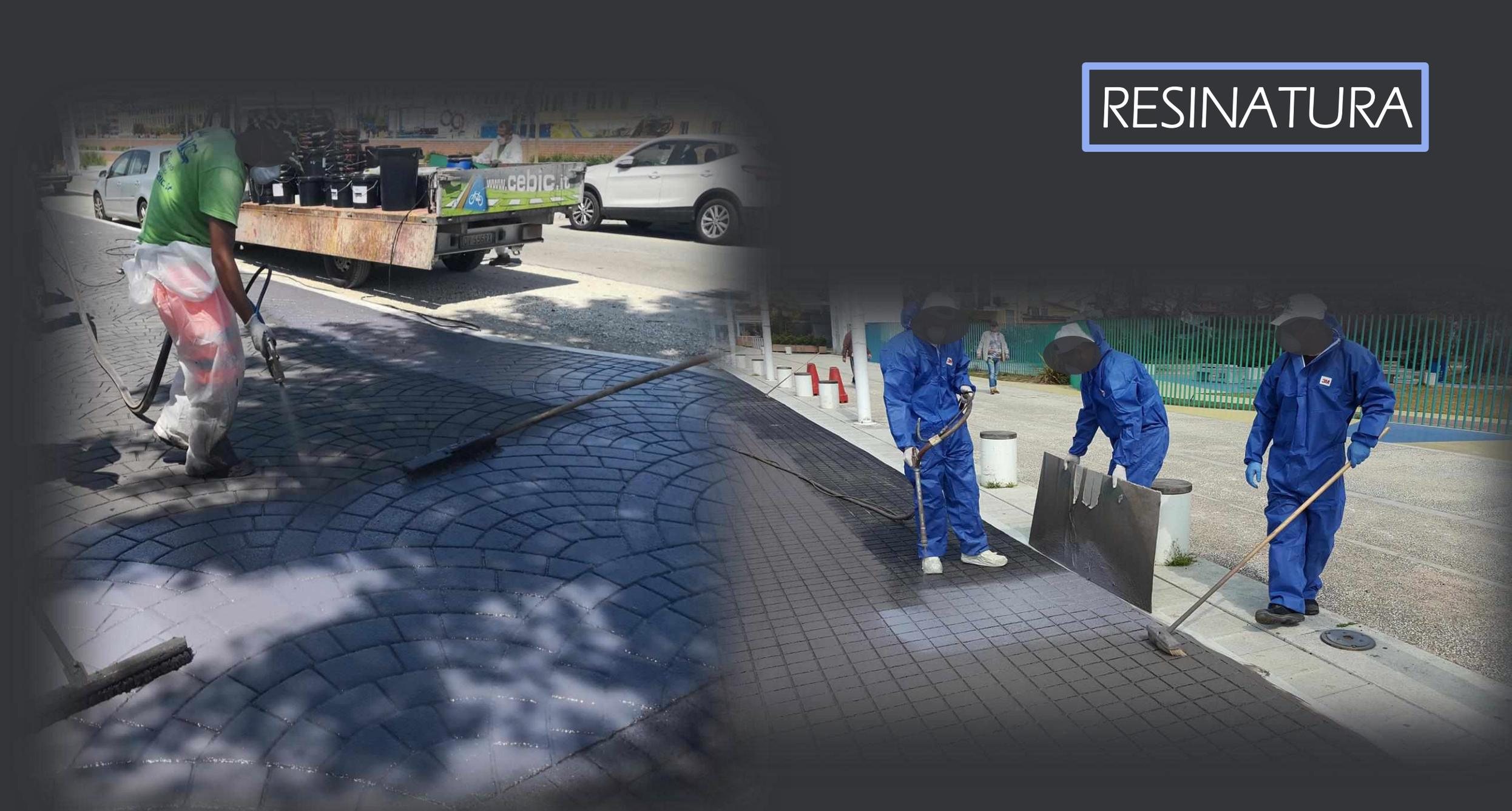
La colorazione dell'asfalto stampato viene eseguita a spruzzo (con apposita pompa a bassa pressione) impiegando un mix di resine acriliche all'acqua, modificate secondo il tipo di intervento :
