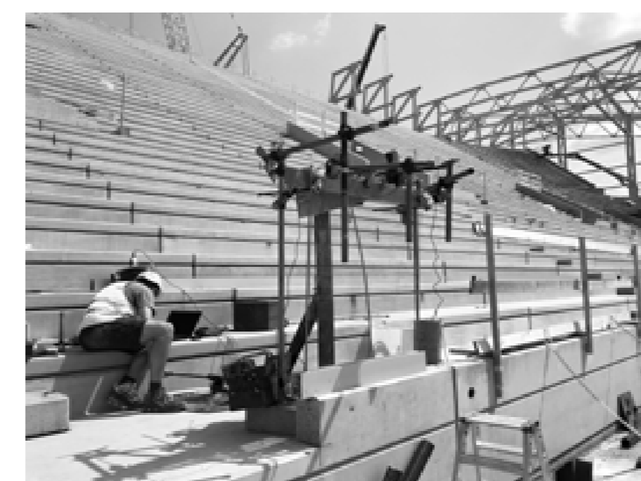
1-2: Fase di test sui parapetti Ninfa allo stadio di Bergamo.
