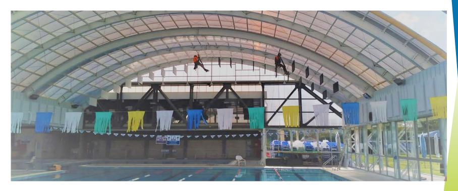
Pannelli Stratocell<sup>®</sup> Whisper<sup>®</sup> 50mm nero a sostituzione dei pannelli bianchi degradati. Installazione da operatori che lavorano in fune su piscina operativa senza fermare l'attività.
