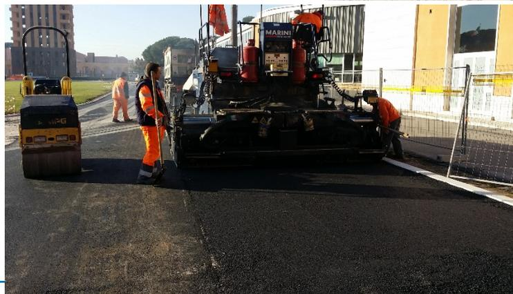
Una menzione di rilievo va fatta sulle pendenze trasversali e longitudinali dell'anello della pista, che devono essere rispettivamente  $\leq 1\%$  in senso trasversale, e  $\leq 0,1\%$  in senso longitudinale, mentre nelle pedane del salto in alto, non devono essere superiori allo 0,6% in senso radiale. La mancata osservanza di queste disposizioni può compromettere l'omologazione dell'impianto di atletica leggera.
