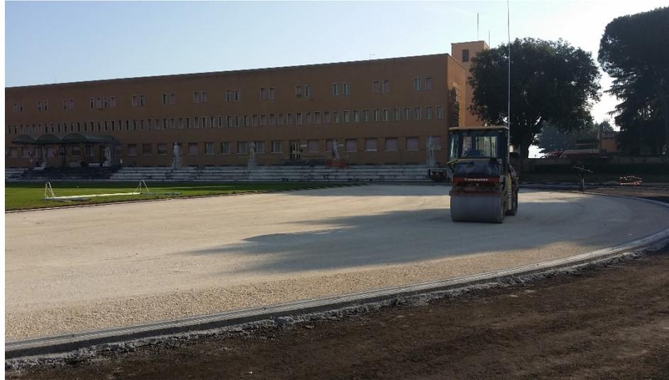
Operazione successiva sarà il montaggio del cordolo esterno prefabbricato in cls e la canaletta interna, avendo cura di controllare relative quote e posizionamento. Questa operazione è importantissima, in quanto, tutte le successive fasi, faranno riferimento alle quote dei cordoli e delle canalette. E' consigliabile tenere un margine di sicurezza restringendo di alcuni centimetri l'interno (verso il centro-pista) ed allargando sempre di alcuni centimetri la distanza del perimetro esterno.
