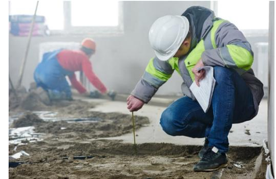
Tutta la superficie di terreno su cui sarà realizzata la pista di atletica, deve essere ben livellata e compattata, in modo da evitare eventuali cedimenti del sottofondo. Lo spessore dell'apporto di materiale inerte compattabile varia a seconda del tipo di terreno di sedime, per cui si dovrà prevedere la quota di imposta in funzione dello spessore di rilevato da realizzare.
