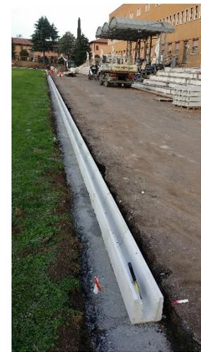
Seguirà quindi il completamento del sottofondo prima della pavimentazione in conglomerato bituminoso; in questa fase è possibile posare lo stabilizzato granulometrico con la vibrofinitrice stradale con regolazione di spessori e pendenze preimpostate con controllo automatico; quest'ultimo può essere elettronico, con raggio laser, o meccanico, con un “palpatore” che scivola sulla superficie orizzontale del cordolo/canaletta. Il tutto andrà compattato con rullo vibrante.
