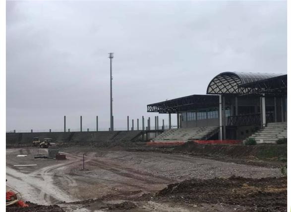
La prima operazione consisterà nel tracciamento topografico dell'ingombro della pista, individuando i centri della parte in curva, le relative tangenti e quindi le parti in rettilineo. E' consigliabile individuare gli assi di mezzzeria sia longitudinali che trasversali, interni ed esterni, con le relative quote altimetriche in modo da avere sempre i riferimenti costruttivi.
