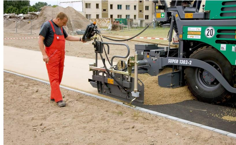
Ultima fase del sottofondo, la posa della pavimentazione in conglomerato bituminoso, eseguita in due strati, Binder e Strato di Usura, i quali verranno stesi sempre con vibrofinitrice stradale, nella medesima modalità utilizzata per l'ultimo strato di stabilizzato.
