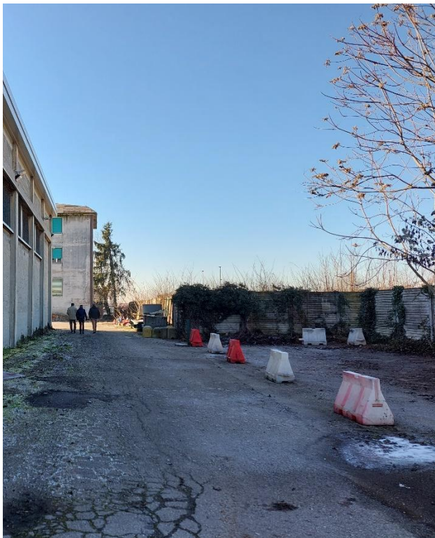
Rilievo fotografico dello stato di fatto.
