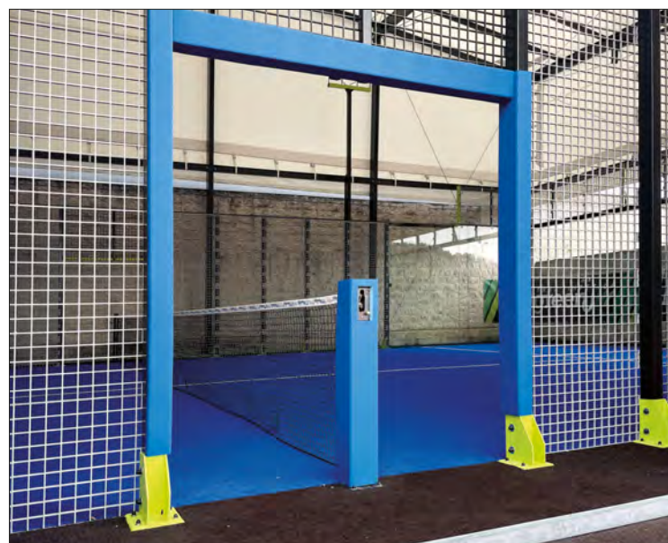
In questa pagina, protezioni nei campi da padel. Nella pagina a lato, in alto, il pavimento Safe Floor nei water park; in basso, protezione lungo i bordi.
