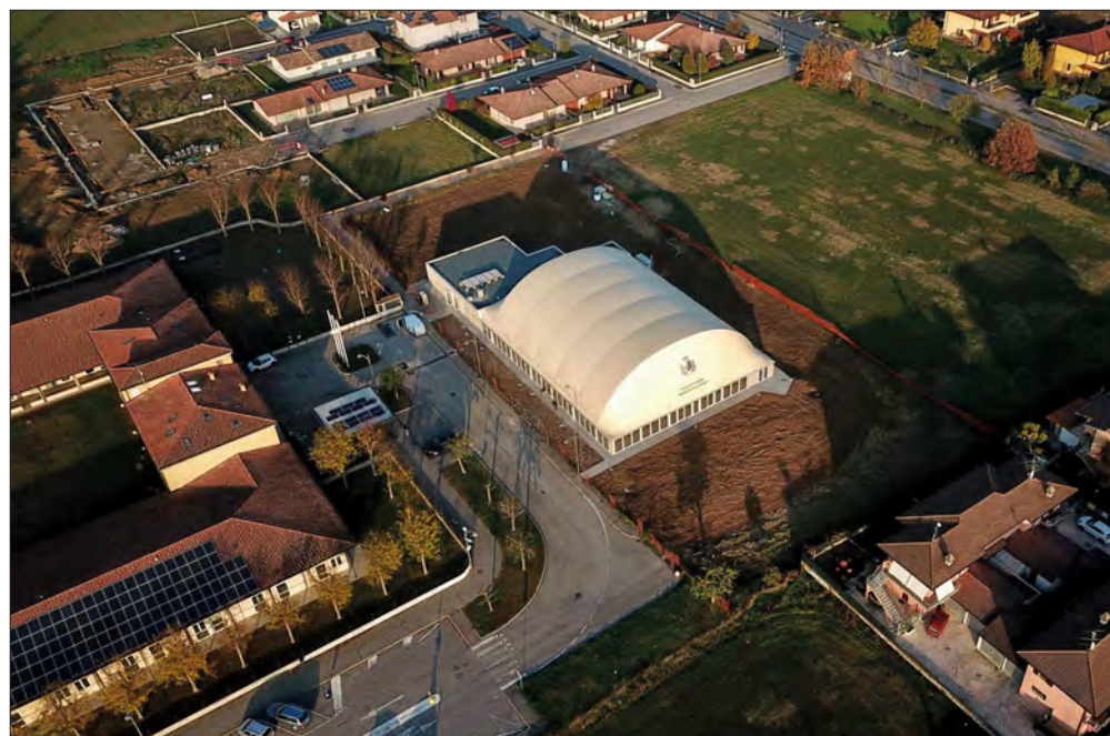
In apertura, la testata interna del palazzetto con l'area canestro. In questa pagina, planimetria generale dell'area di intervento e foto a volo d'uccello. Nella pagina destra, pianta del palazzetto.
