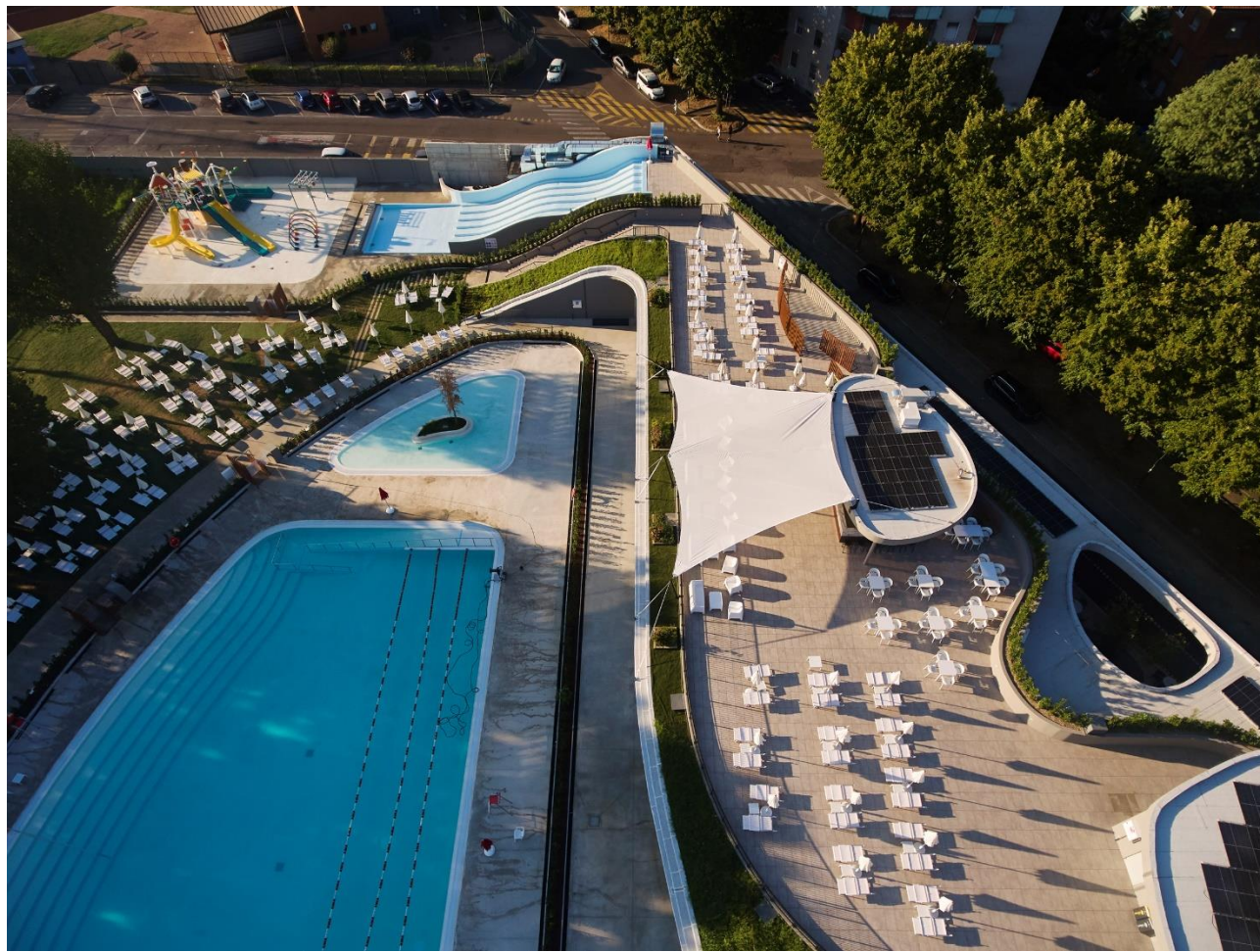
Bar e Solarium al piano coperture
