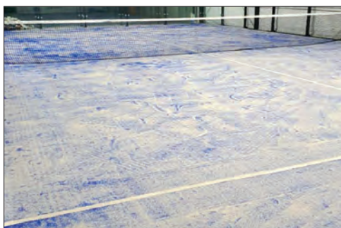
Nella pagina sinistra, in alto, campi con manto fibrillato e intaso in sabbia visibile alla superficie (foto Officine d'Amico). In basso, vista zenitale del Casilino Sky Park a Roma: i tre campi da padel sono pavimentati con resina acril-sintetica al caucciù, con disegni di Giulio Vesprini (foto IGT).
