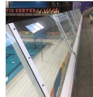
**FISSAGGIO A TERRA E BASE:** non idoneo a livello statico per i carichi previsti per la destinazione d'uso. Presenza di ruggine e corrosione galvanica/ammaloramento. Cordolo in C.A. troppo ridotto per i carichi in gioco.
