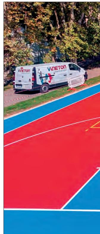
clata) legato e colato in opera mediante idonea vibrofinitrice. Nella realizzazione del tappetino, modificando la granulometria della gomma, la sua compattezza e lo spessore, si può controllare il ritorno elastico della pavimentazione, determinandone le caratteristiche prestazionali e di sicurezza.
