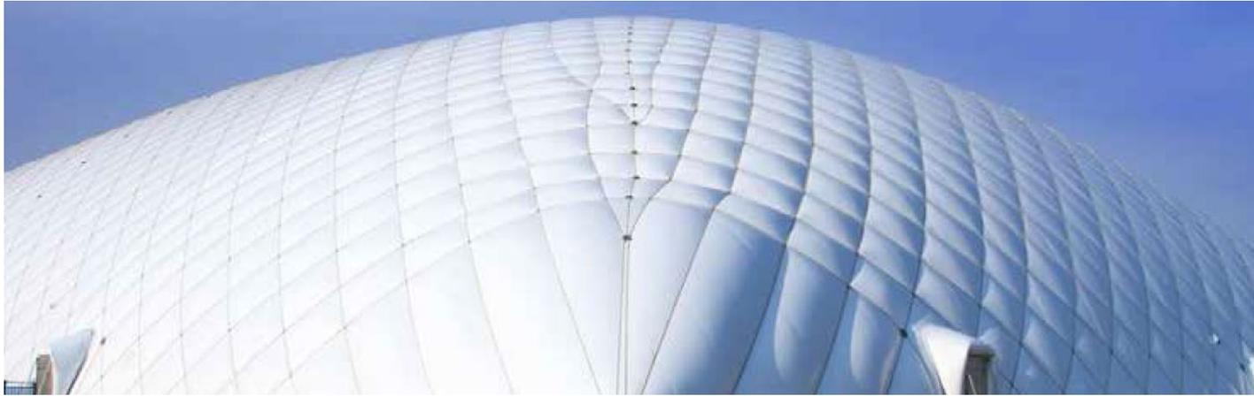
Le *pressostrutture* sono moderne coperture senza la classica struttura portante rigida in ferro/legno. La caratteristica principale delle pressostrutture è il fatto che sono sostenute dalla pressione atmosferica interna.
