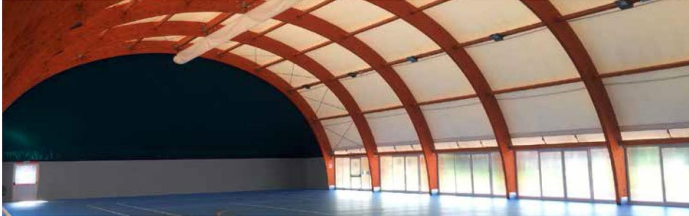
Una *tensostruttura* è un edificio realizzato con materiali mantenuti in posizione tramite tensione.
