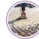
PAVIMENTAZIONI ARCHITETTONICHE IN PIETRA
