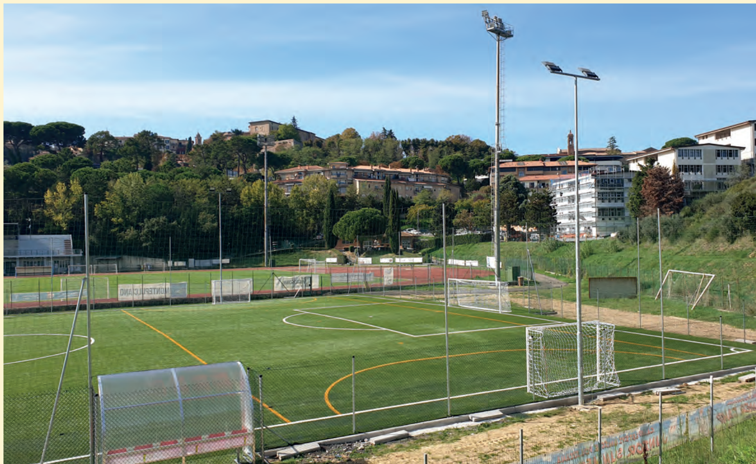
Uno scorcio del nuovo campo di calcio a 7, adiacente alla pista di atletica; sono visibili gli elementi illuminanti, le recinzioni, le porte e la panchina realizzati dall'impresa esecutrice "chiavi in mano".
