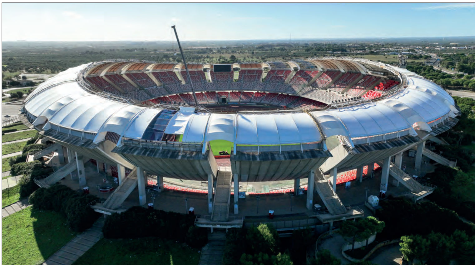
Qui sopra, il San Nicola nella fase di completamento dei lavori. Nella pagina destra, in prima colonna, pianta delle coperture e due sezioni. Nella seconda colonna, un dettaglio del progetto originario e tre immagini dei teli di copertura (tutte le foto: Riglietti per Tsport).
