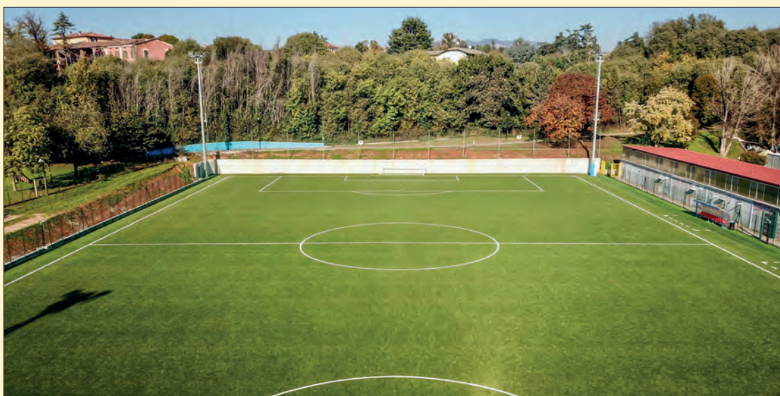
A sinistra vista generale del centro sportivo. In questa pagina, in alto, l'area dedicata al calcio. Nelle altre foto dettagli dei campi a 11 e a 7 riqualificati da Mast.
