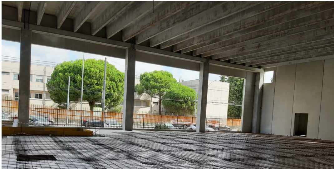
Struttura prefabbricata in calcestruzzo armato
