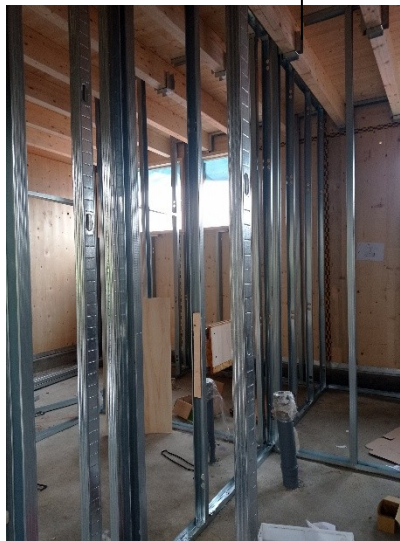
Pareti divisorie interne realizzate a secco
