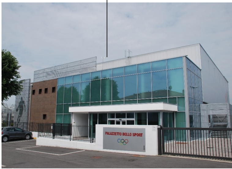
Copertura in alluminio
