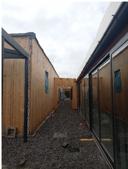
Pareti strutturali e velette in x-lam
