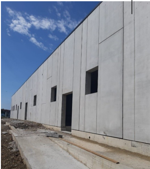
Tamponamenti perimetrali con pannelli prefabbricati in calcestruzzo coibentati
