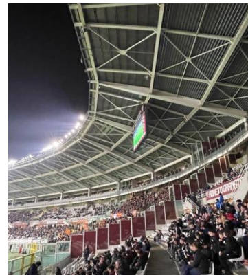
Separatori di segregazione alti 2.2m dal piano di imposta (Stadio Olimpico Grande Torino)
