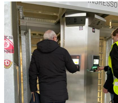
varchi a tutt'altezza, accesso area di servizio annessa all'impianto
