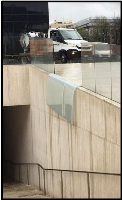
Vetri temprati stratificati con PVB e rottura accidentale di entrambe le lastre.
