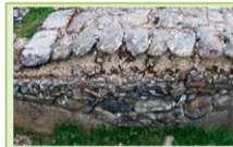
Sezione di una strada in epoca romana
