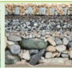
Sezione pavimentazione drenante
