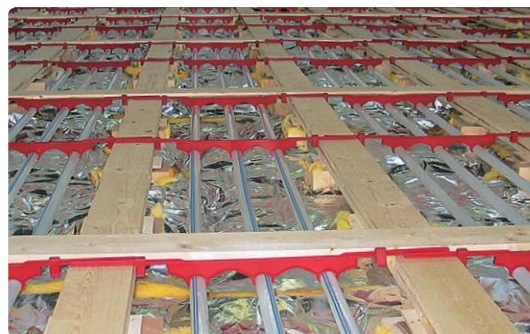
Pavimento sportivo flettente a superficie elastica con riscaldamento per pavimento flettente Uponor integrato
