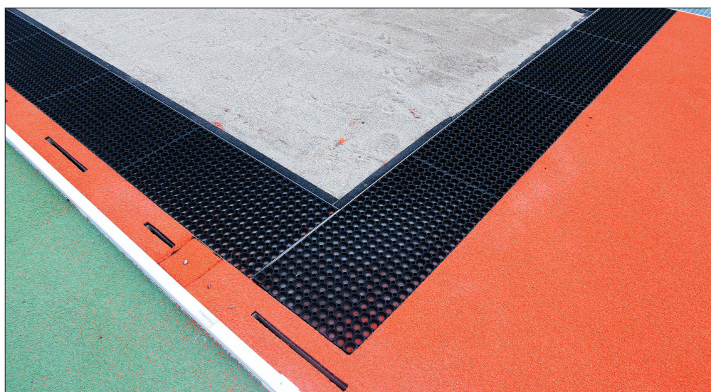
La fossa del salto lungo il rettilineo ovest, e un particolare della griglia disabbiatrica.
