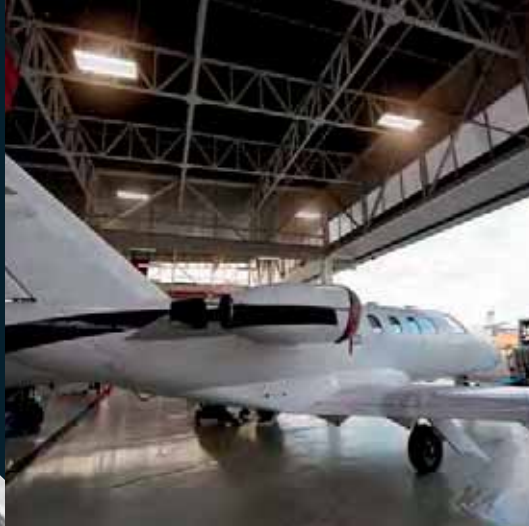
Illuminazione ad alte prestazioni per grandi capannoni industriali con soffitti alti.
