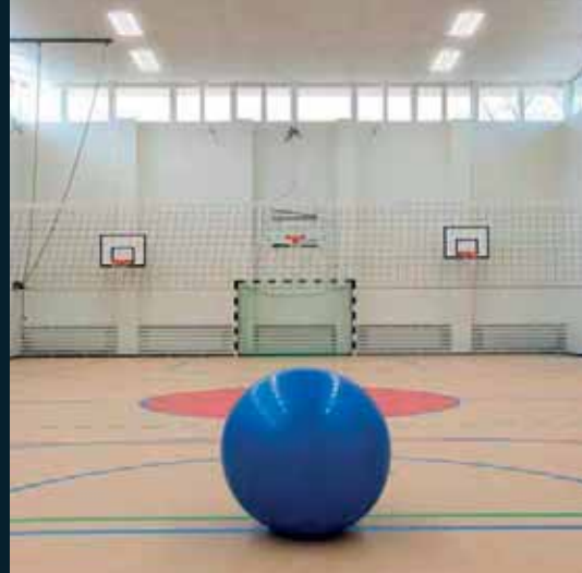
Illuminazione certificata a prova di palla per un utilizzo sicuro e duraturo in impianti sportivi al coperto.
